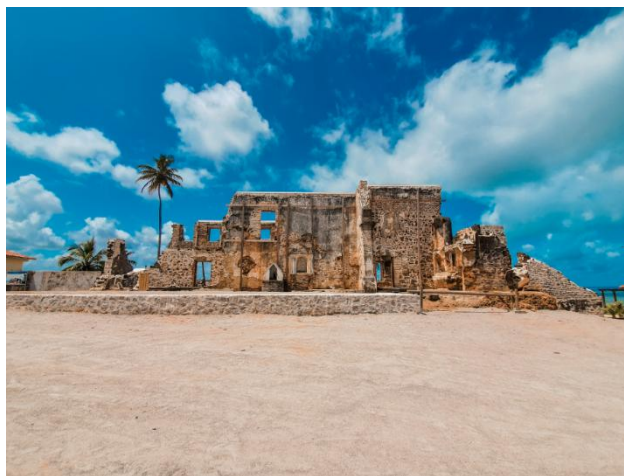
Foto 01 – Vista frontal da Ruína da Igreja de São Bento Distrito de São Bento, Maragogi - AL
