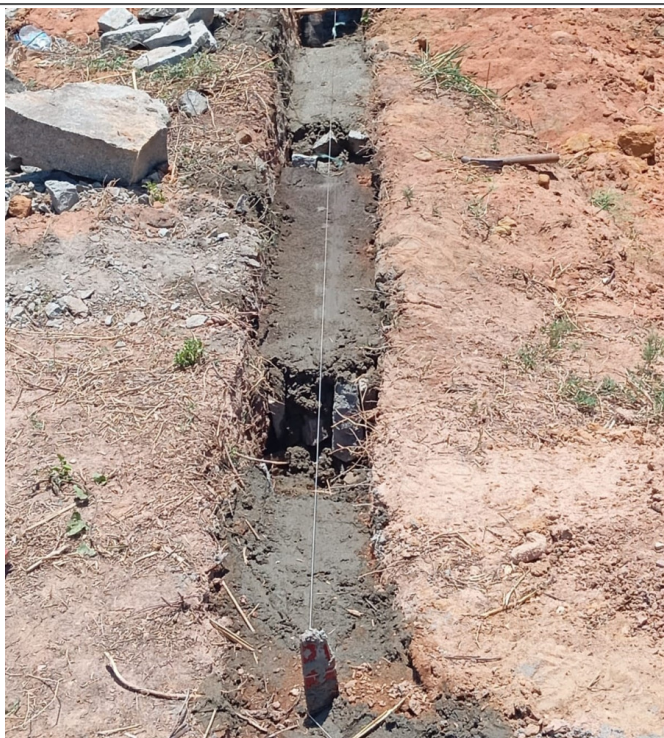
- Fixação de estacas pré-moldadas de concreto, para o alambrado.
