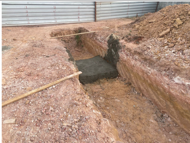
- Escavação mecanizada de vala com retroescavadeira;
