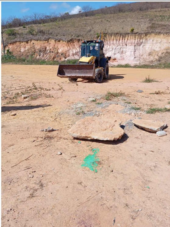
- Escavação mecanizada de vala com retroescavadeira;
