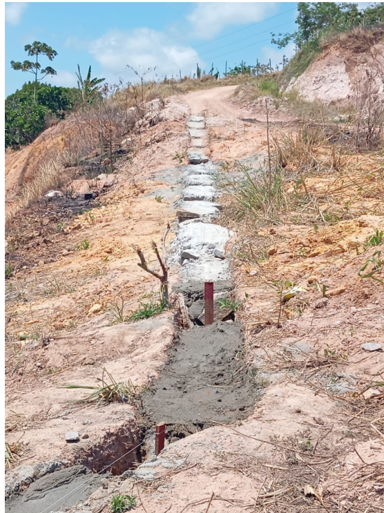
- Base para alvenaria com pedra rachão
