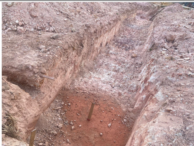
- Escavação mecanizada de vala com retroescavadeira;
