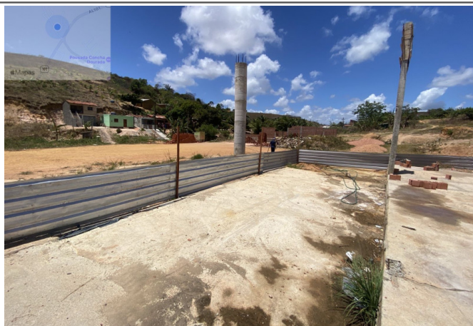
- Instalação de tapume com telha metálica;
