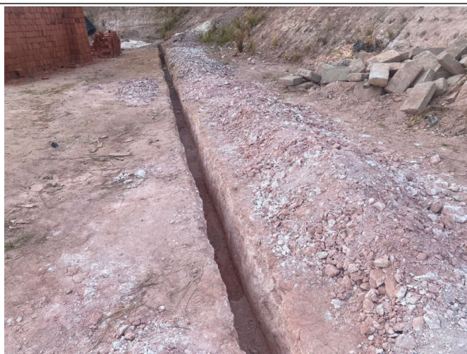
- Escavação mecanizada de vala com retroescavadeira;
