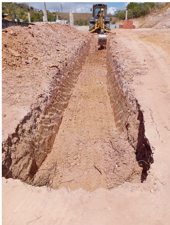
- Escavação mecanizada de vala com retroescavadeira;
