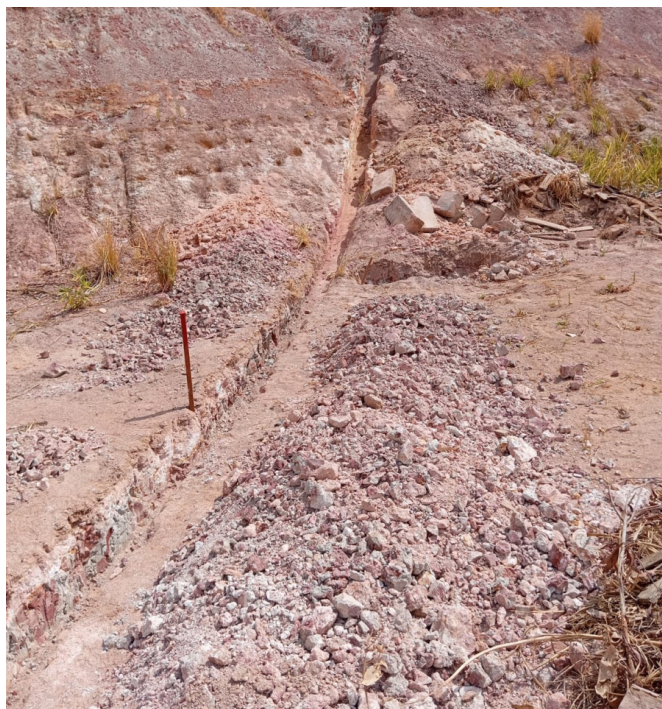
- Escavação mecanizada de vala com retroescavadeira;
