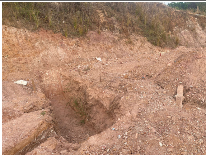
- Escavação mecanizada de vala com retroescavadeira;
