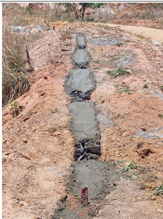
- Base para alvenaria com pedra rachão
