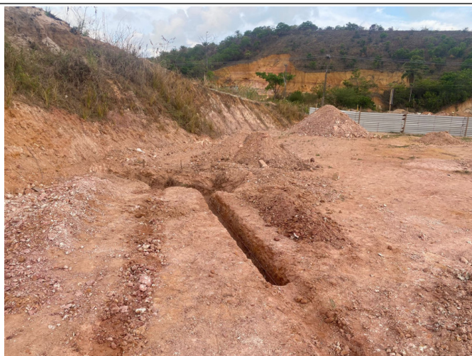
- Escavação mecanizada de vala com retroescavadeira;
