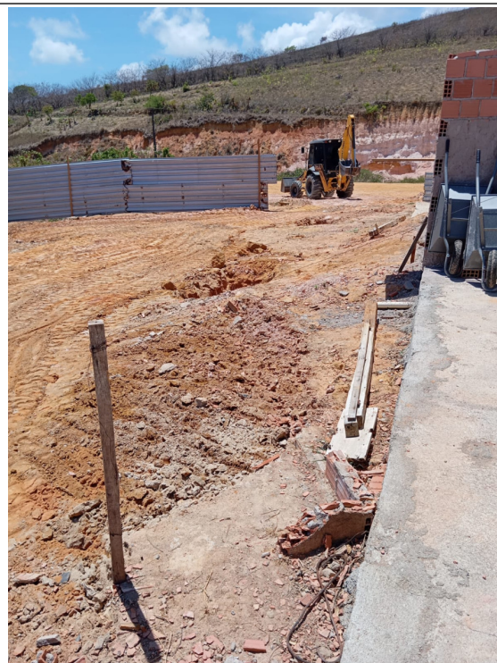
- Instalação de tapume com telha metálica; - Escavação mecanizada de vala com retroescavadeira;
