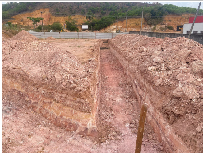
- Escavação mecanizada de vala com retroescavadeira;
