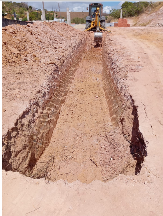
- Escavação mecanizada de vala com retroescavadeira;
