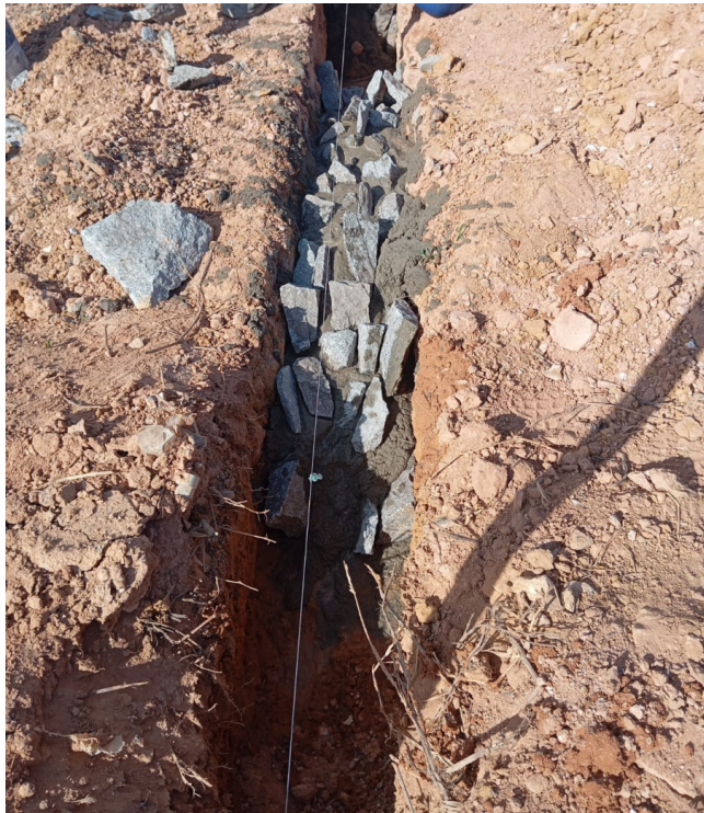
- Base para alvenaria com pedra rachão
