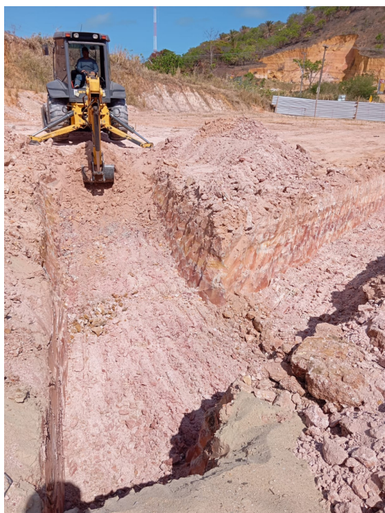
- Escavação mecanizada de vala com retroescavadeira;
