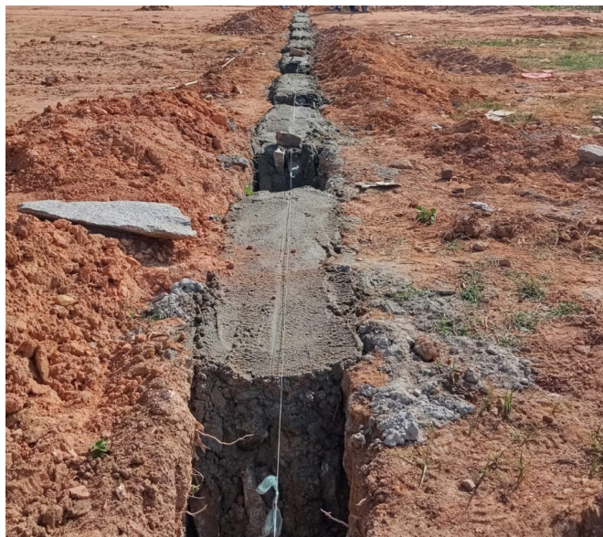
- Fixação de estacas pré-moldadas de concreto, para o alambrado.
