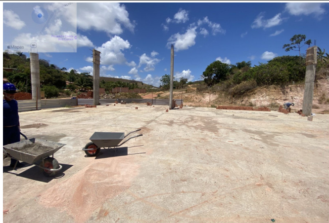
- Instalação de tapume com telha metálica;
