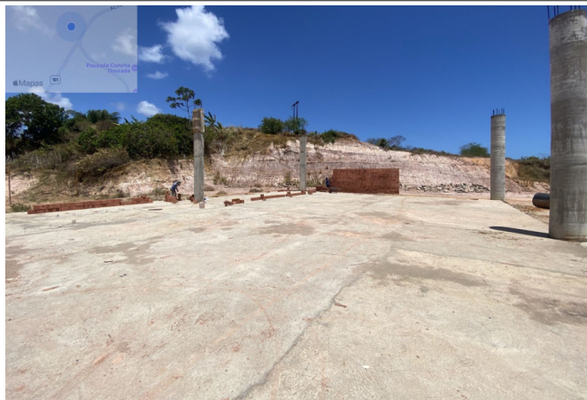
- Instalação de tapume com telha metálica;
