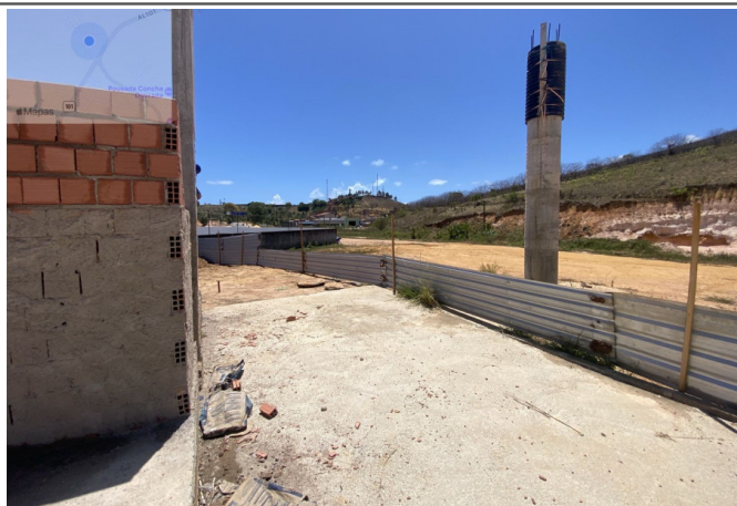
- Instalação de tapume com telha metálica;
