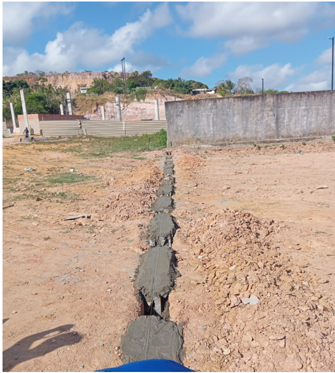
- Base para alvenaria com pedra rachão
