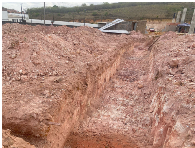
- Escavação mecanizada de vala com retroescavadeira;
