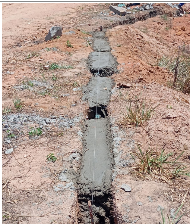
- Base para alvenaria com pedra rachão
