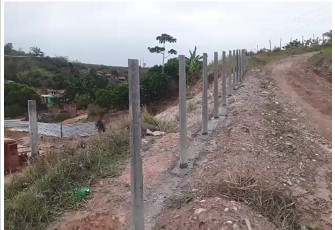
- Base para alvenaria com pedra rachão; - Fixação de estacas pré-moldadas de concreto, para o alambrado.
