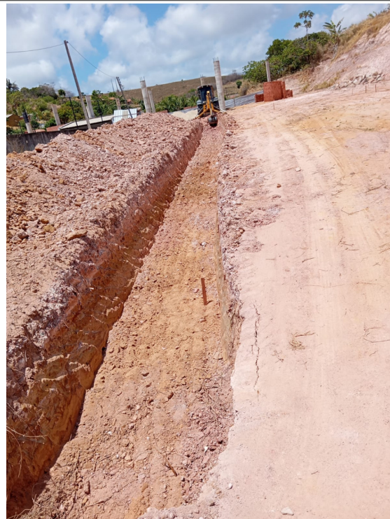
- Escavação mecanizada de vala com retroescavadeira;
