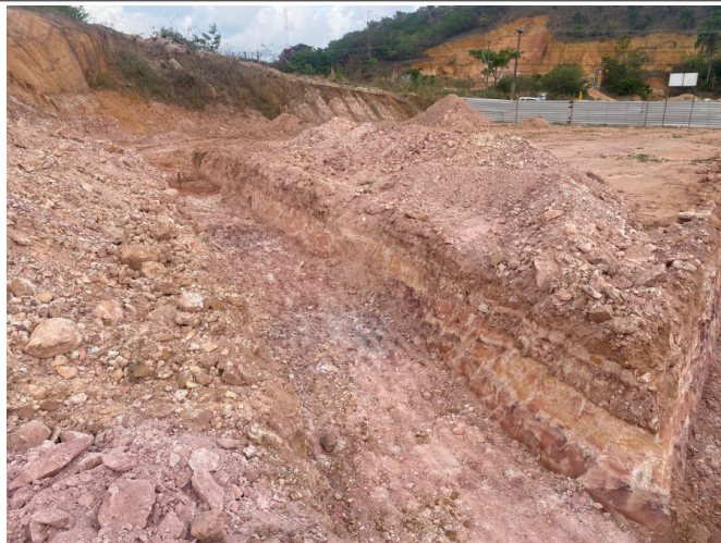
- Escavação mecanizada de vala com retroescavadeira;
