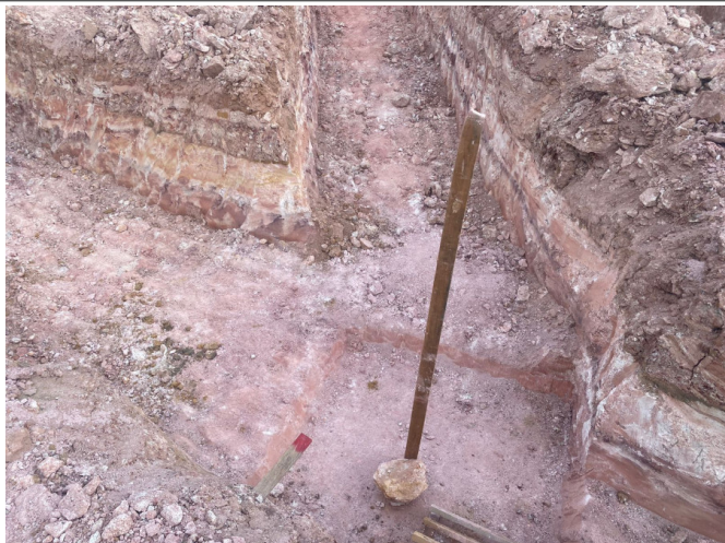
- Escavação mecanizada de vala com retroescavadeira;
